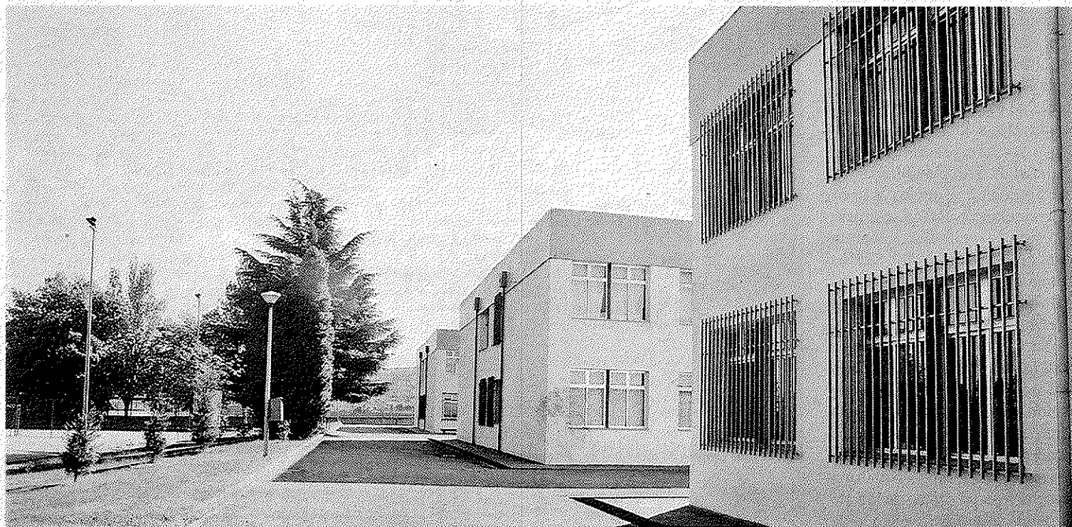
Obras de requalificação e modernização vão dotar a escola, entre outros, de um auditório, salas de dança e espaços de aprendizagem individual de instrumentos
